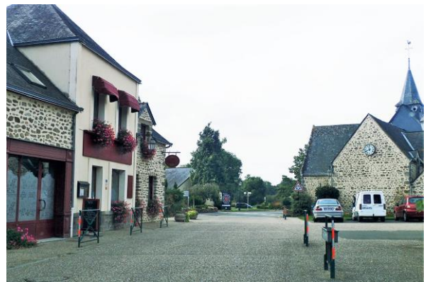
Photo 39 : Centre-bourg (La Bazoges-Montpinçon)
