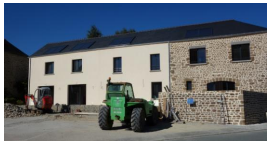
Photo 25 : Projet de rénovation (Le Horps)
