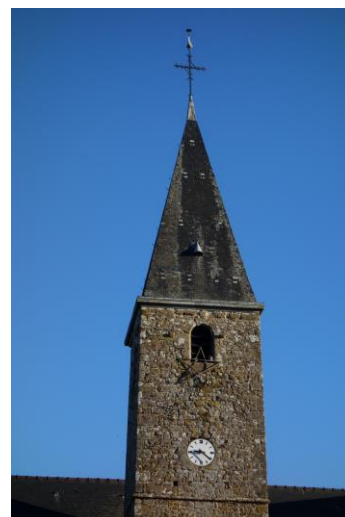
Photo 35 : Clocher servant de gîte pour les chiroptères (Champéon)
