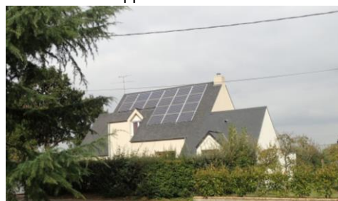
Photo 46 : Panneaux solaires (Commer)
