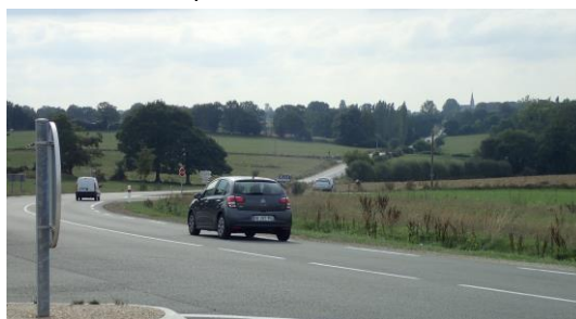
Photo 4 : Déviation de la RN 162 (Moulay)
