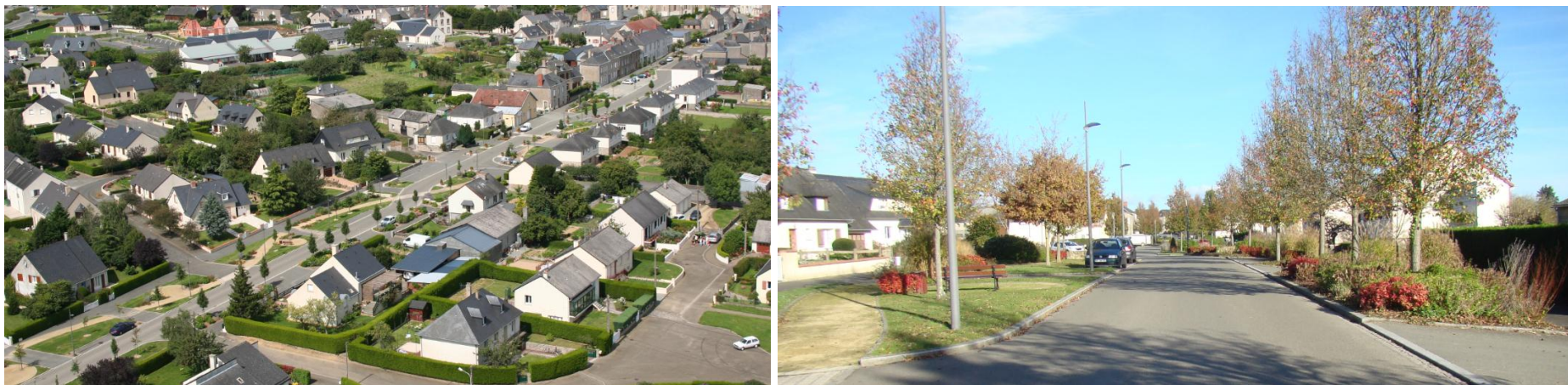
Aménagement de la voie principale de Martigné-sur-Mayenne
