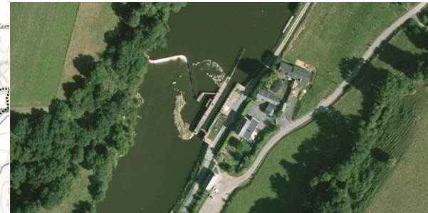
Ecluse et barrage de Bousard
