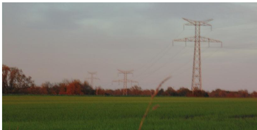
Ligne de 90 kV à proximité du bourg
