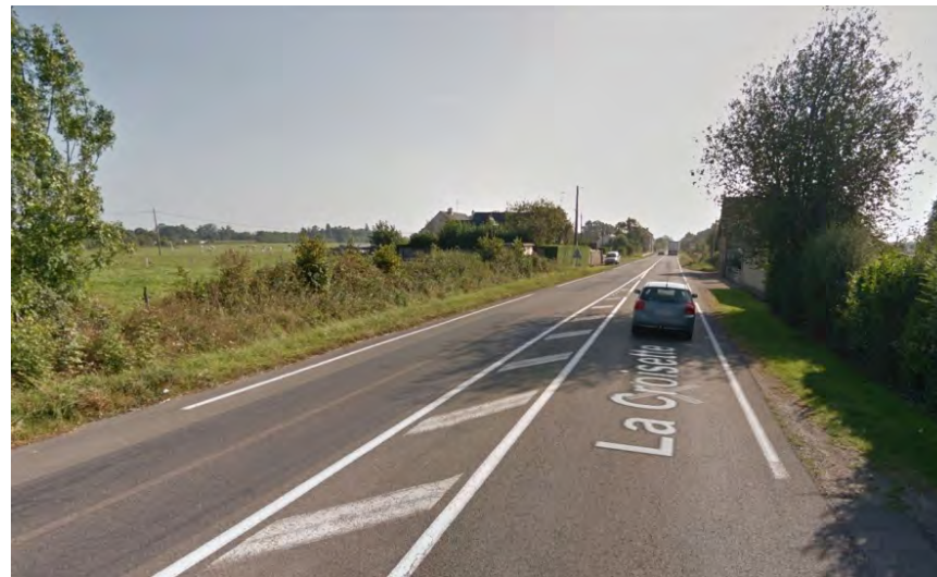
RD 35 au Sud de la zone d'étude
