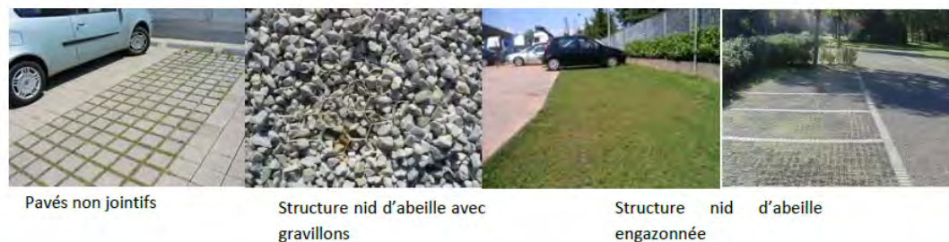
Illustration 3 : Types de revêtements perméables pour les allées piétonnes ou les aires de stationnement
