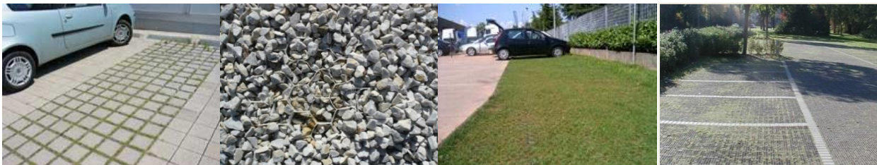
Pavés non jointifs
