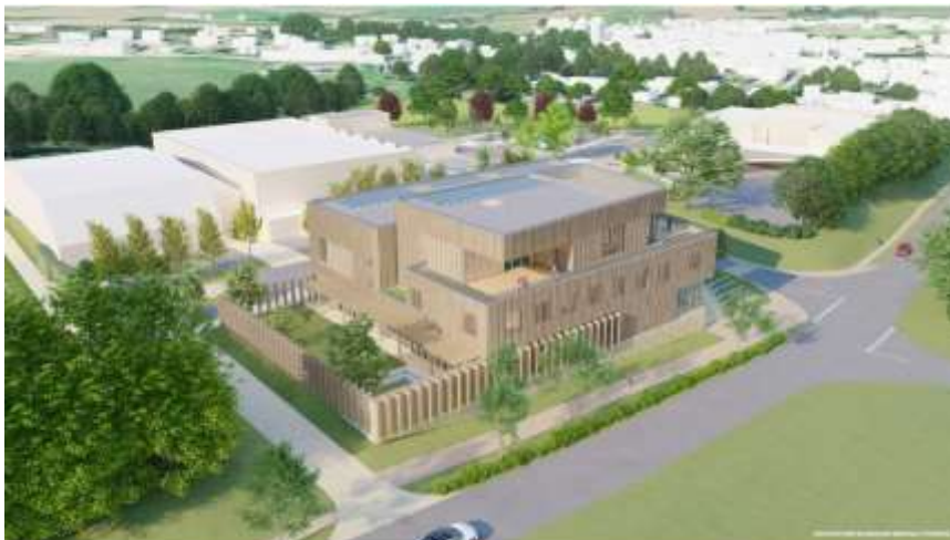
VUE AÉRIENNE DÉTAILLÉE DU BÂTIMENT
